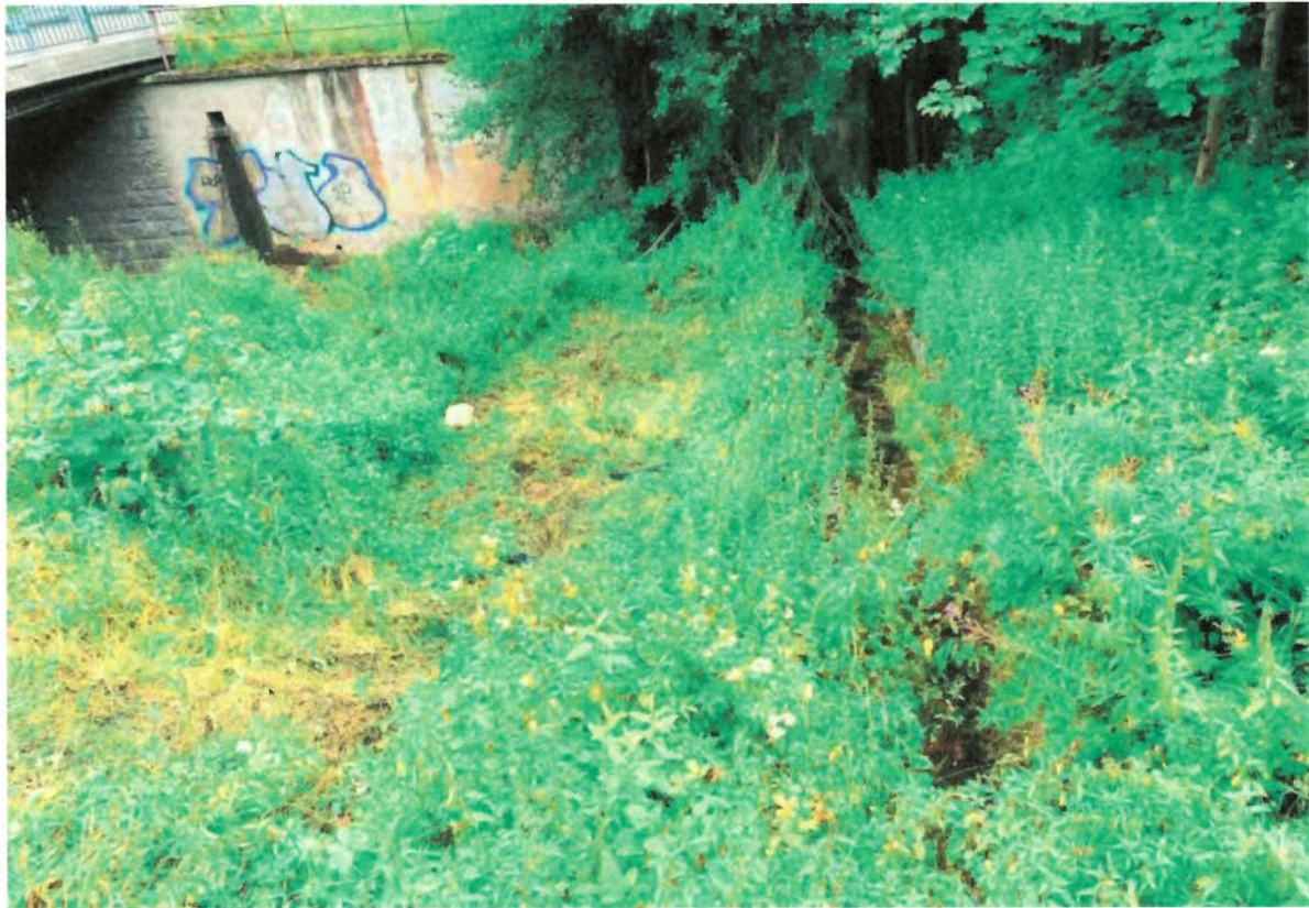
Foto 01: Zulauf in die Steina
