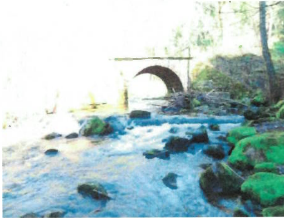
Foto 01: Absturz (U St 06)
